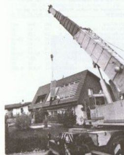
Bild 2 zeigt die Montage der Luftkollektoren, die wegen des nachträglichen Einbaus von der Strasse her mit einem Autokran bewerkstelligt werden musste, dafür aber in einer halben Stunde erledigt war.
