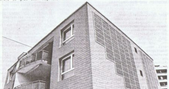
Erstmals in der Schweiz wird in diesen Tagen eine Solarfassade im Mietwohnungsbau die Stromproduktion aufnehmen. 60 Quadratmeter Solarzellen sorgen in dieser Überbauung in Zürich für einen jährlichen Energieertrag von 6000 kWh. Die Solar-zellen sind in der Aussenfassade der Wohnhäuser anstelle von Fassadenelementen eingepasst. Mit dieser Pflanzenlage
