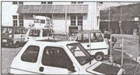
ParkRide-Anlage für Elektro- und Solarmobile der ADEV in Liestal. Vorne rechts die Steckdosen, in Bildmitte die zentrale Kontrollmeseinheit und im Hintergrund die 2,6 kW-Netzverbundsolaranlage.
