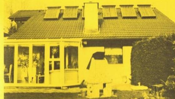
Wohnhaus P. Schibli in Altstätten: SOL 100 plus Vakuum-Röhrenkollektoren auf einen 800 Liter-Speicher zur Erzeugung von Warmwasser mit etwas Schwimmbad- und Heizungsunterstützung.
