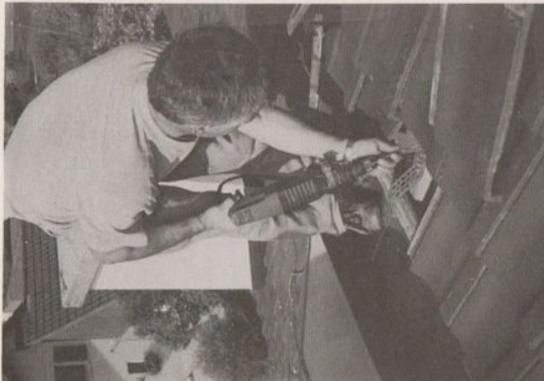
3 Die Befestigungsbügel werden auf dem Dach angefertigt und mit der Lattung verschraubt.
