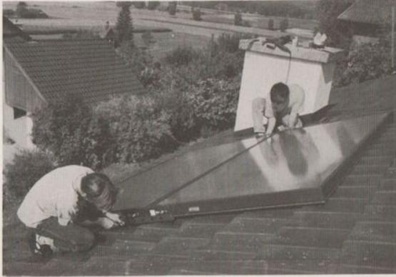
7 Beginn der Montage: Die beiden Kollektoren werden miteinander verschraubt.
