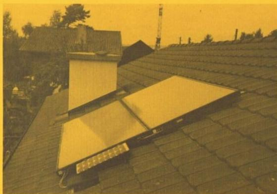
**Titelbild:** Die 6 m<sup>2</sup> Warmwasserkollektoren auf dem Dach des 20-jährigen Hauses von K. Isler, Dörflingen, sind über eine ausserhalb der Gebäudehülle geführten "Lifeline" mit einem, dem bestehenden Boiler vorgeschalteten, Wärmetauscher verbunden. Das 17 W-Solarpanel treibt die Pumpe direkt an.
