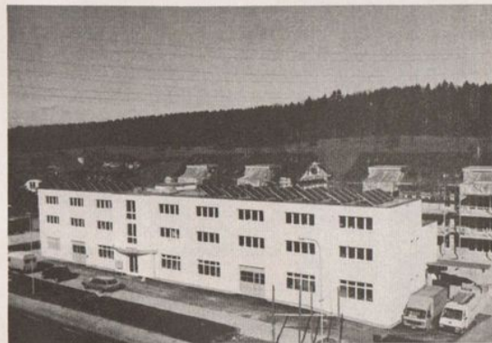
Auf dem Flachdach die beiden Kollektorfelder, die im Winter die Raumheizung des Gewerbebaus ermöglichen. Sommerliche Überschusswärme dient der Warmwasseraufbereitung in den dahinter liegenden Wohnhäusern.
