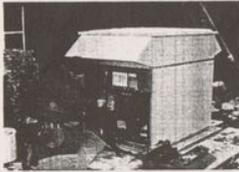
**10** Hinter der vorderen Verkleidungswand findet der Elektriker alle Vorrichtungen für den Anschluß der Wärmepumpe. Ein Anschlußwinkel erlaubt den schnellen und einfachen Zugriff auf die zu verdrehenden Elemente
