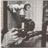
**11** Die Pufferspeichen-Ladepumpe (Bild) und die Umwälzpumpen für den Heizkreis werden angeschlossen
