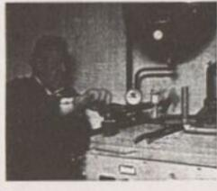
Der 1800-Liter-Ölkessel wird leert gepumpt und zerlegt. Der gewonnene Platz dient jetzt als zusätzliche Lagerfläche für Koffer und Diskussionsrunden
