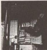
**12** Im Schaltschrank laufen sämtliche Kabel zusammen. Der Wärmepumpen-Manager WPM ist herein integriert. Er regelt die gesamte Heizungs-Anlage
