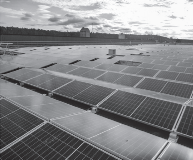
Blick vom Dach gegen Südwesten mit dem GVS-Silo.
